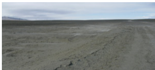
Зураг 6. Лабораторийн шинжилгээнд хамруулаагүй, ширхэглэлийн бүрэлдэхүүнээрээ шаардлага хангаагүй материал дэвссэн байдал
